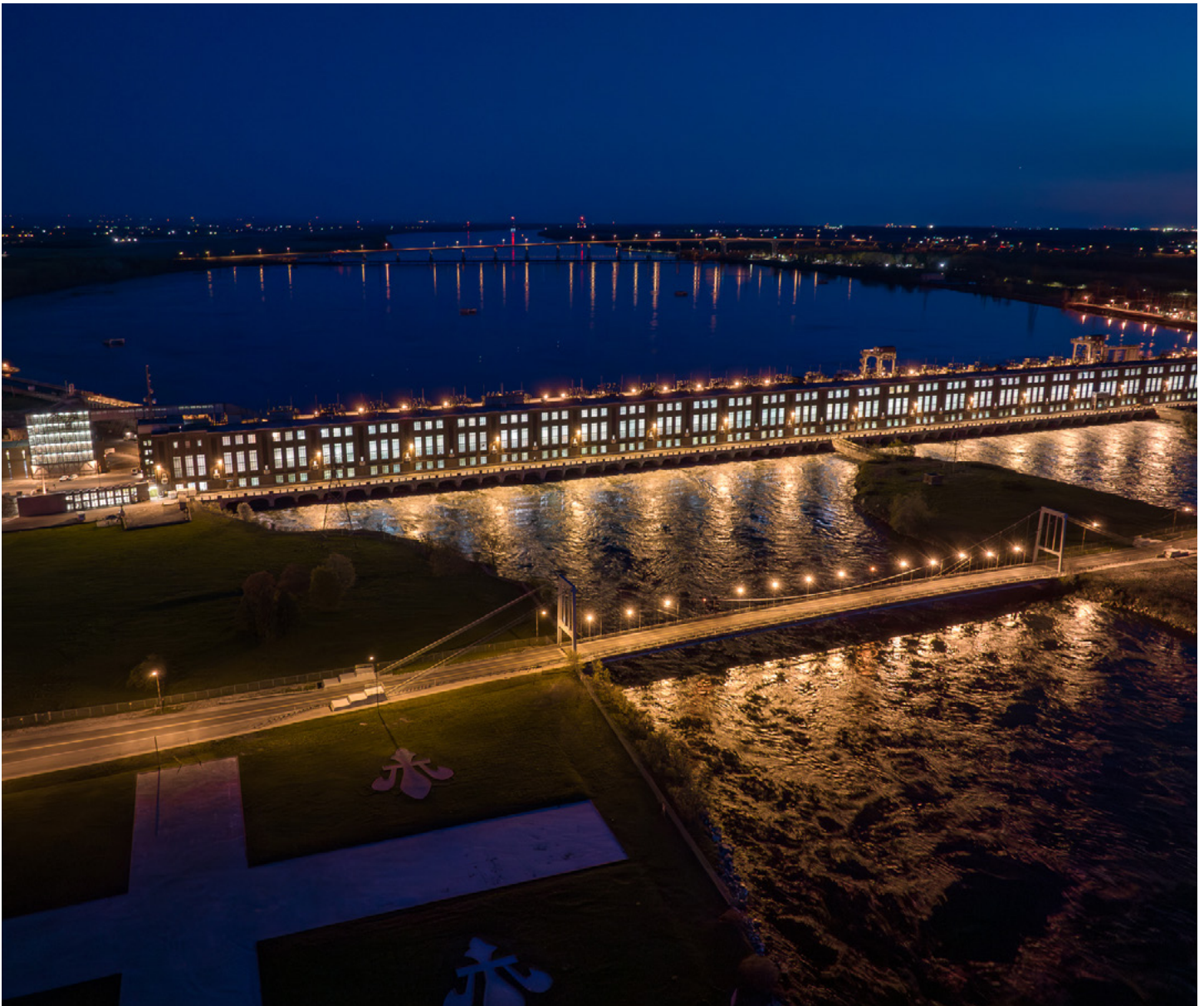
La centrale de Beauharnois.
