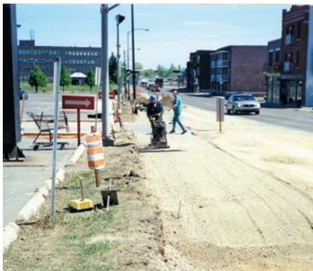
5. Remblayage et surfacage
