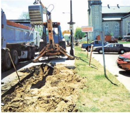
1. Excavation sous le trottoir
