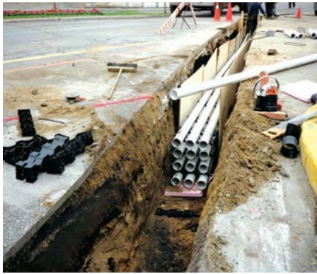
3. Installation du coffrage pour le bétonnage
